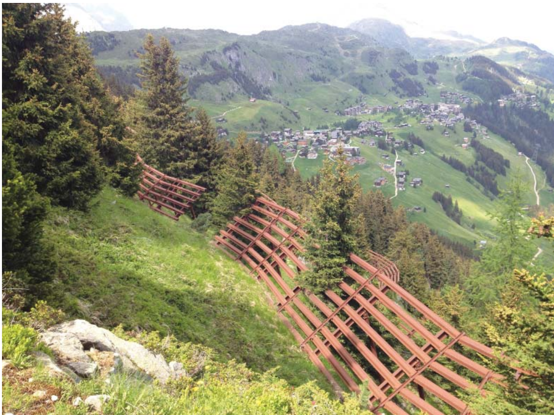
ზვავლამჭერი ნაგებობები, შვეიცარიის ალპები
